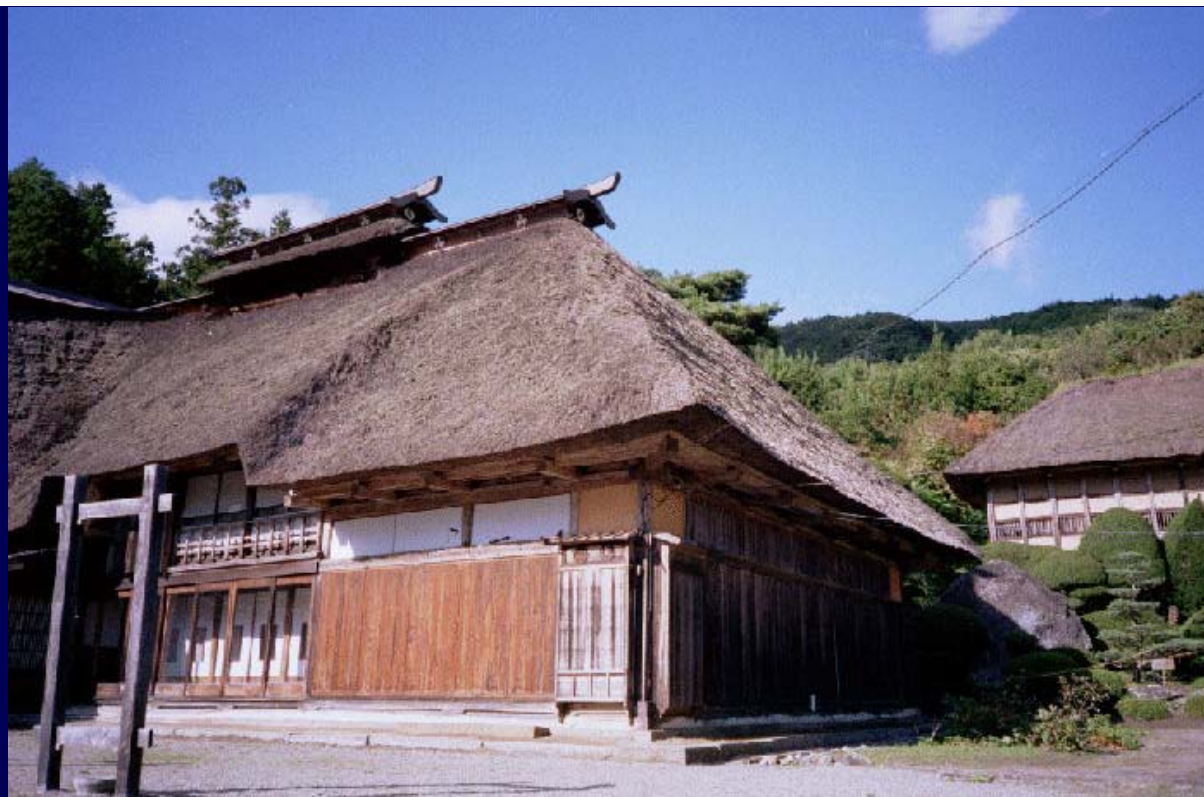
人が暮らす母屋の部分。後ろには巨石がさりげなくあった。
