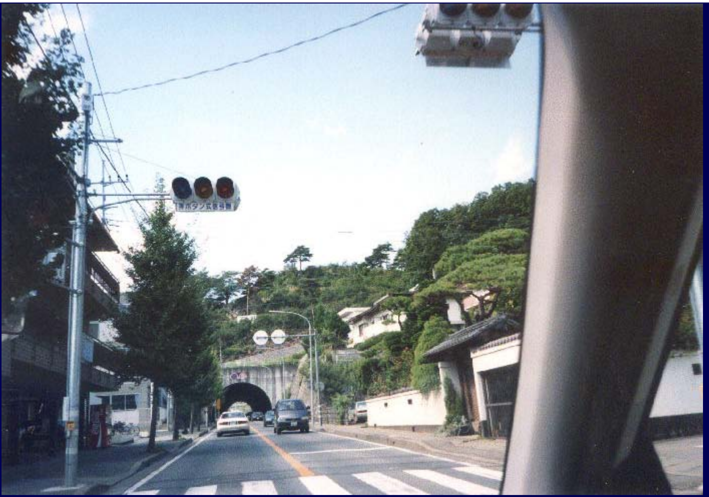
酒折宮の裏手山に貫通するトンネル。
