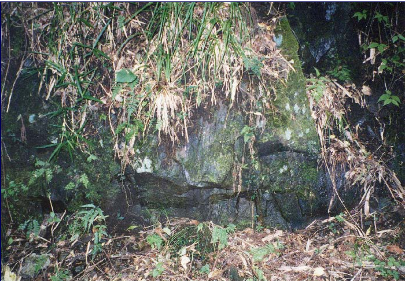
参道途中の岩肌の状況。
