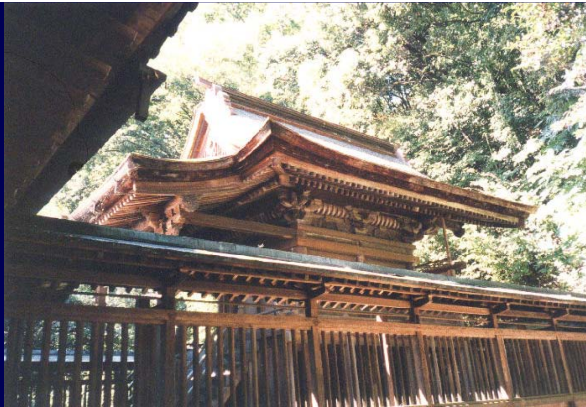
明治40年に国の重要文化財に指定された山梨岡神社の本殿。
