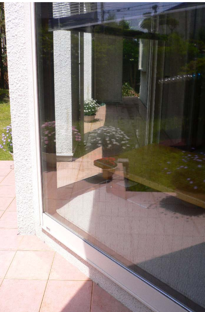
『遊縁』はTOTO製陶器パネルタイル300角のはめ込みにより設置。隅切り部分は全てグラインダーによるカット。
